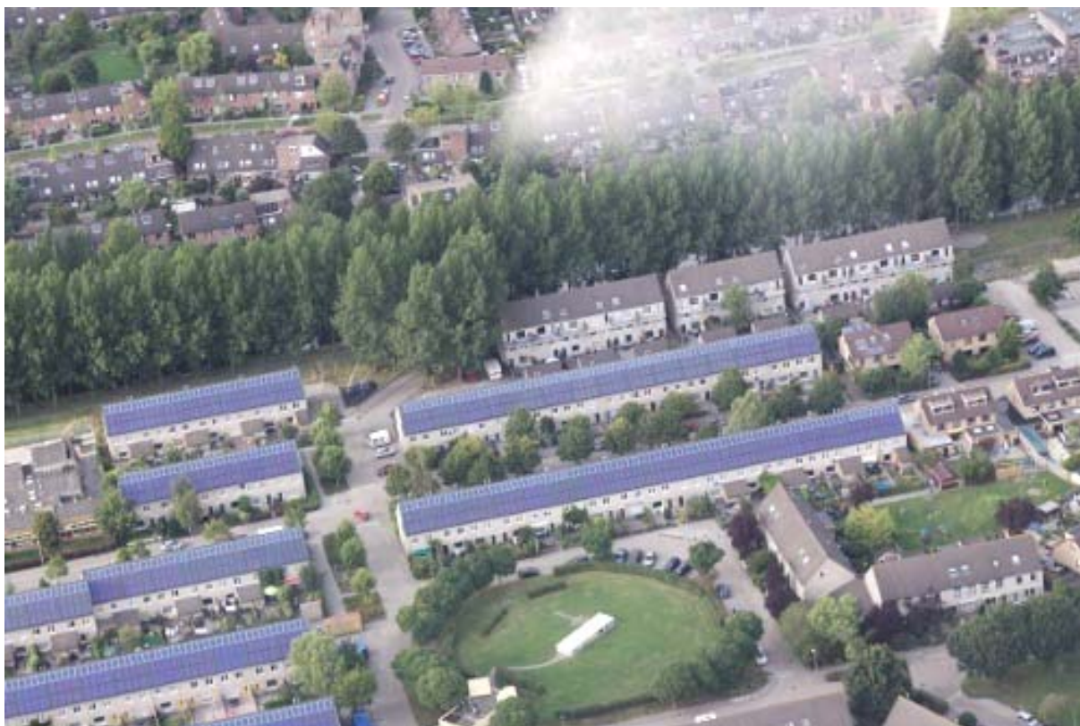
Renovatieproject van 96 huurwoningen aan de Froukemaheerd in Beijum, de woningen hebben zonneboilers en zonnepanelen.
