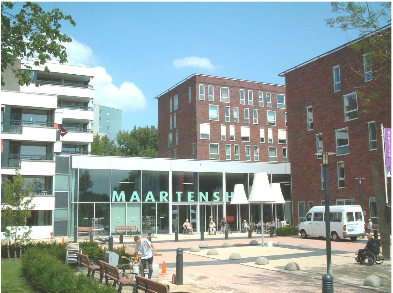
Het geheel gemoderniseerde verzorgings- en verpleeghuis Maartenshof in de woonwijk Hoornse Meer, het huis is in april 2009 heropend.
