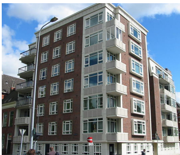
Figuur 2 De Plantsoenflat uit 1950 aan de Westersingel één van de oudste voorbeelden van na-oorlogse hoogbouw.
