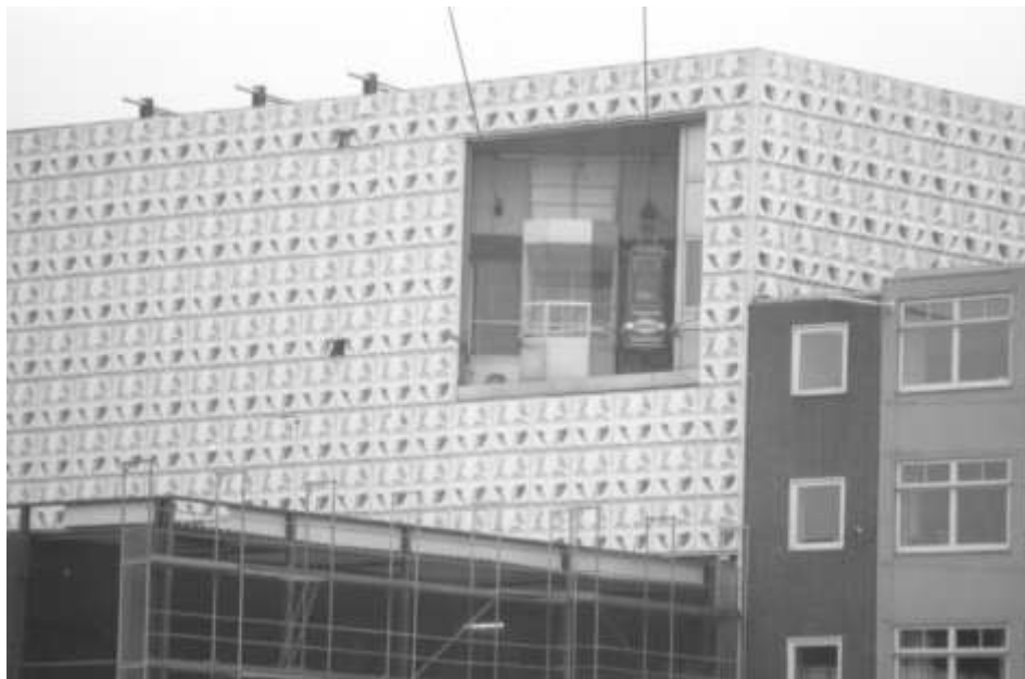
Station geïntegreerd in gebouw (Kiel Duitsland)
