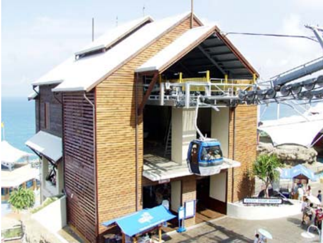
Gecamoufleerd station (pretpark China)
