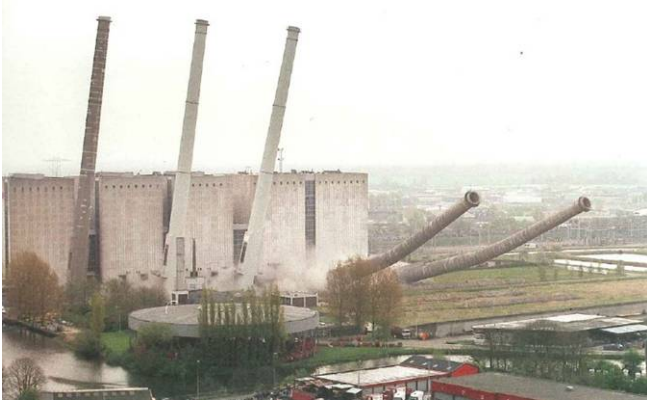
Sloop Hunzencentrale 25 april 1998
