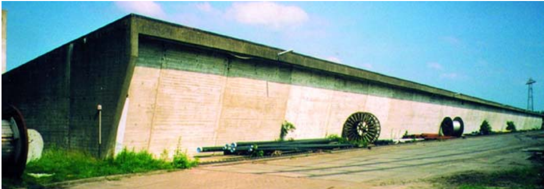
Kolenmuur in oorspronkelijke staat
