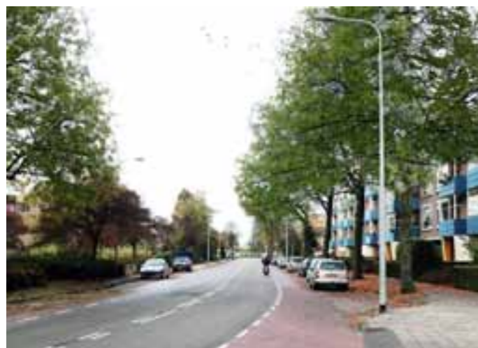
Foto bestaande situatie t.h.v. Werumeus Buningstraat
